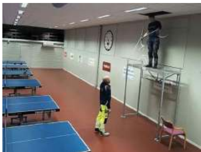
KABELKARER: Leif-Harald Svendsbråten og Jonas Jensen skjulte de skjemmende nettverkskablene langs vegger og tak - over himlingen.
