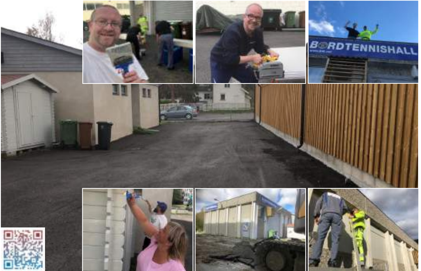
OPPGRADERT: Gamle asfaltrester er erstattet med frest asfalt. Utearelene framstår i ensartet form. Boden er malt og sprukne vinduer dekket.
