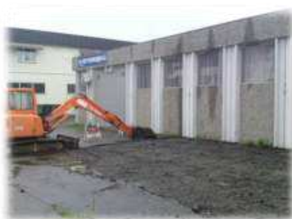
13.09.11: Graving utført av Brødrene Øiom AS
