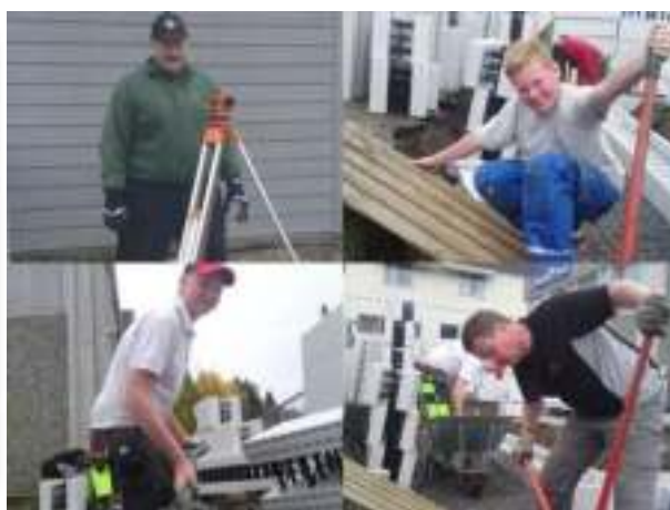
02.10.11: Bygging med fokus på Rune, Alexander, Kenneth og Jan Tore. Totalt 24 dugnadstimer.
