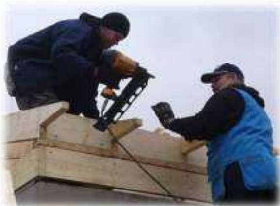
05.11.11: Takarbeid. Bendik og Rune spikrer med trykkluftmaskin. Duoen er kledd for anledningen.
