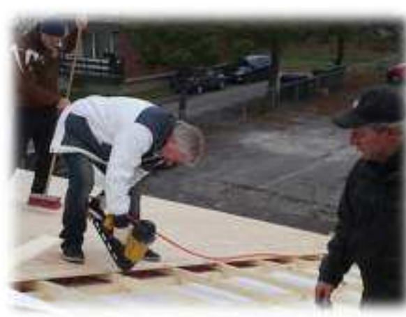
13.11.11: Takarbeid med Åge, Erik og Tom som tre av åtte arbeidere denne søndagen.
