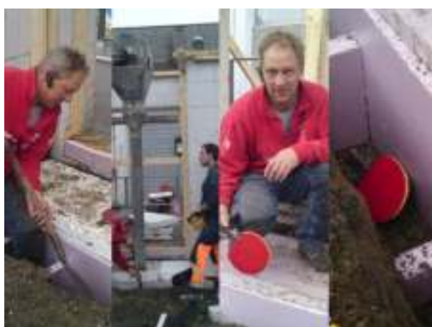
27.10.11: Veggstøping. Tom la ned grunnsteinen.
