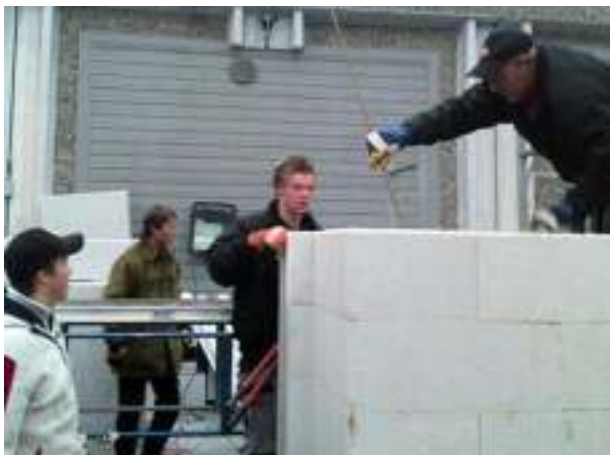
25.10.11: Vegg-bygging med ivrige deltakere, og som alltid med byggmester Tom i spissen.
