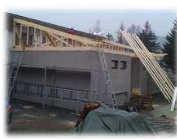
05.11.11: Takarbeid. Skråtaket tar form. Tilbygget er i ferd med å få tak over seg.
