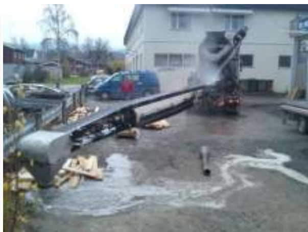
27.10.11: Veggstøping. Holtet Pukk og Betong stilte med utstyret og gjorde jobben.
