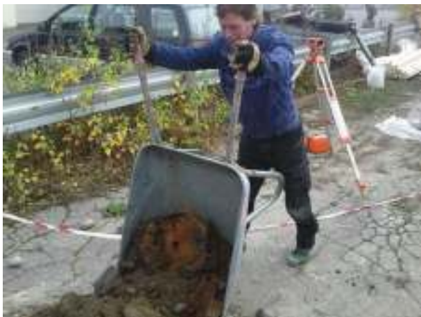
01.10.11: Byggestart med Bjørn Erik i aksjon. Utgravingen er tøff og krevende.
