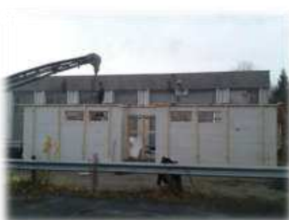
27.10.11: Veggstøping. Det begynner å likne noe...
