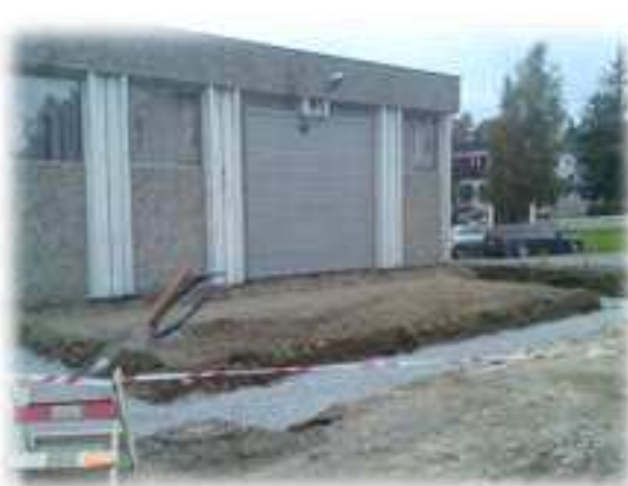
21.09.11: Graving utført av Brødrene Øiom AS
