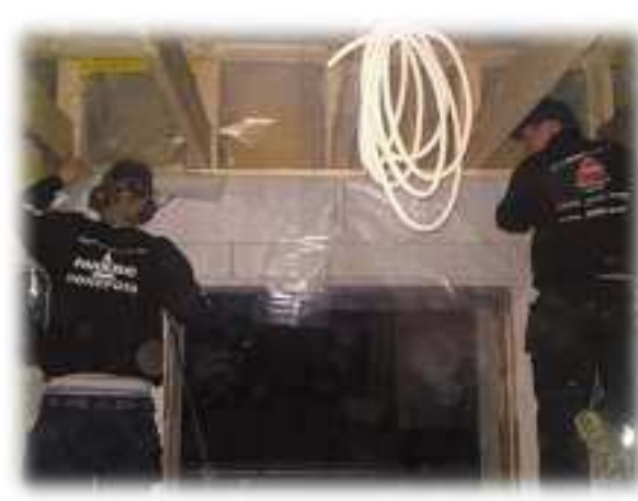
27.11.11: Isoleringsforberedelser: Halvard og Tom tar jobben! Isolasjonen sprøytes inn senere.
