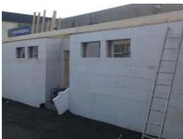
30.10.11: Vegger og tak. Veggene er oppført. Mye forarbeid kreves for å gå i gang med selve taket. Heldigvis lar snøen og vinteren vente på seg.
