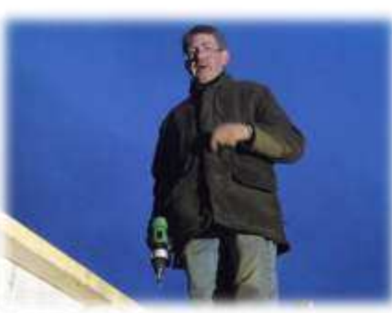
26.10.11: Støpeforberedelser med John Petter som debuterende ressurs høyt og lavt!
