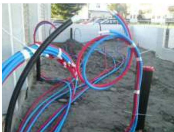
18.10.11: Rørleggerkabler som Randsfjord Rørservice beundringsverdig ordnet for JBTK.
