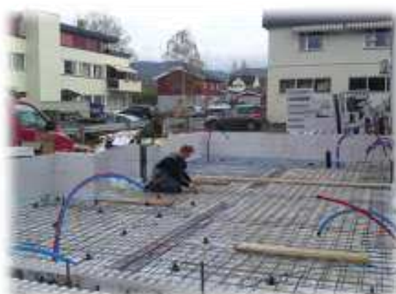
22.10.11: Varmekabel-legging ledet av Magnus M. Velo fra Jevnaker Elektriske.
