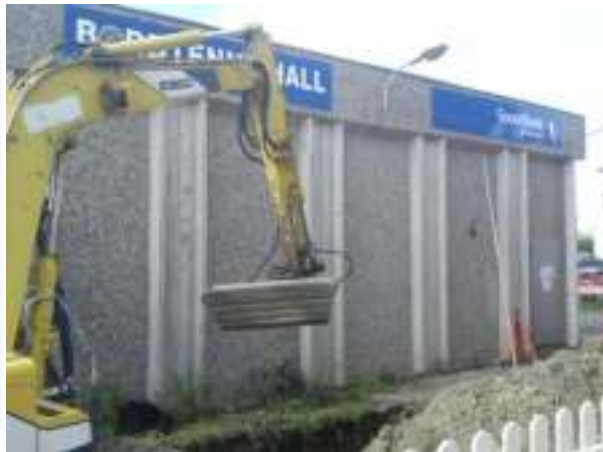
14.09.11: Graving utført av Brødrene Øiom AS
