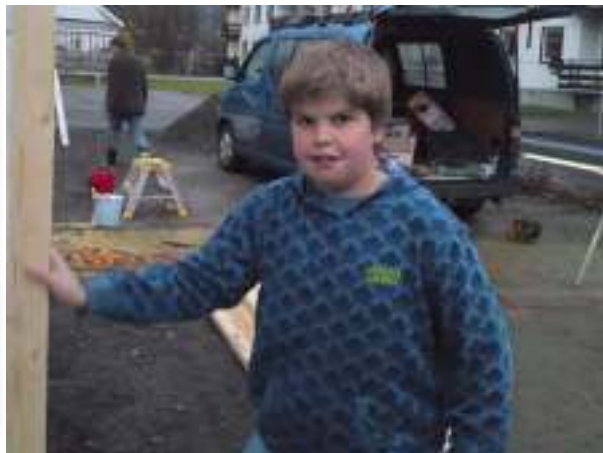
26.10.11: Støpeforberedelser med Thomas som ivrig medhjelper.
