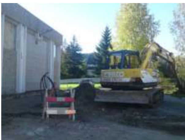
16.09.11: Graving utført av Brødrene Øiom AS
