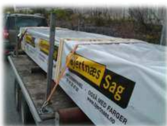
27.10.11: Veggstøping. Men også transport av mer trevirke, utført av Thomas.
