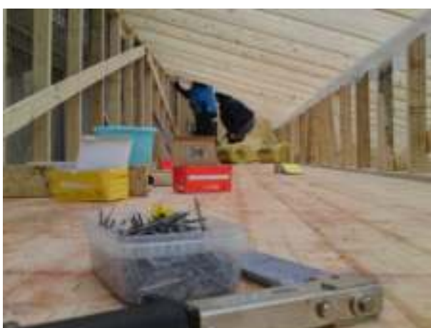
05.11.11: Takarbeid. Her på loftet blir det plass til oppbevaring av mye forskjellig.
