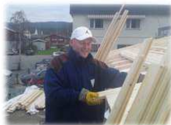
12.11.11: Takarbeid. Sven Ivar var én av åtte JBTK-arbeidere i aksjon denne novemberlørdagen.
