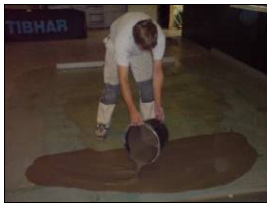
SLUKSTØP: Jan tetter slukene med betong.
