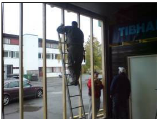
NYE VEGGER: Isolering av leddportene fra utsiden.
