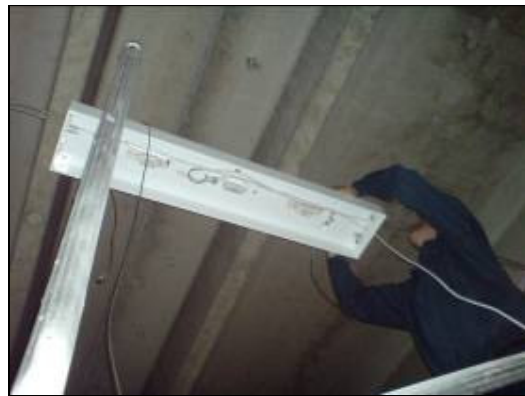
LYSERE: Sverre har montert seks nye taklysarmaturer.
