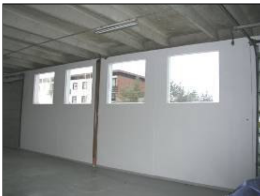
HVITE VEGGER: Slik så veggene og vinduene ut.
