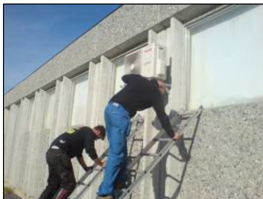
BRØRBY: Varmepumpeinstallatører fra Brørby & Sønn.
