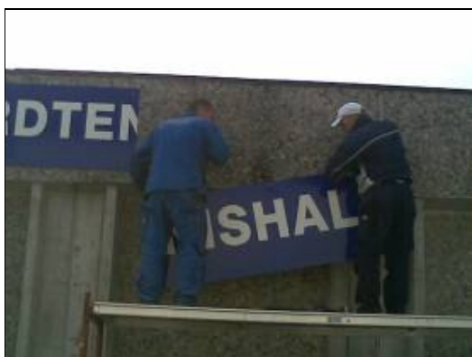
JEVNAKER BORDTENNISHALL: Arbeidet går framover.
