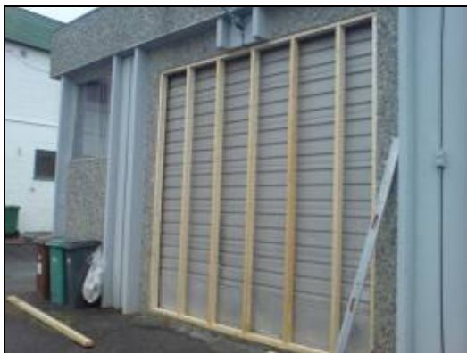
LAGARBEID: Mange bidro til å få opp ytterveggene.
